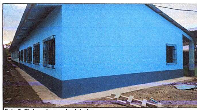
Foto 5: Pintura de paredes interior.
