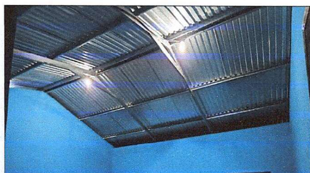
Foto 4: Instalación de sistema eléctrico.
